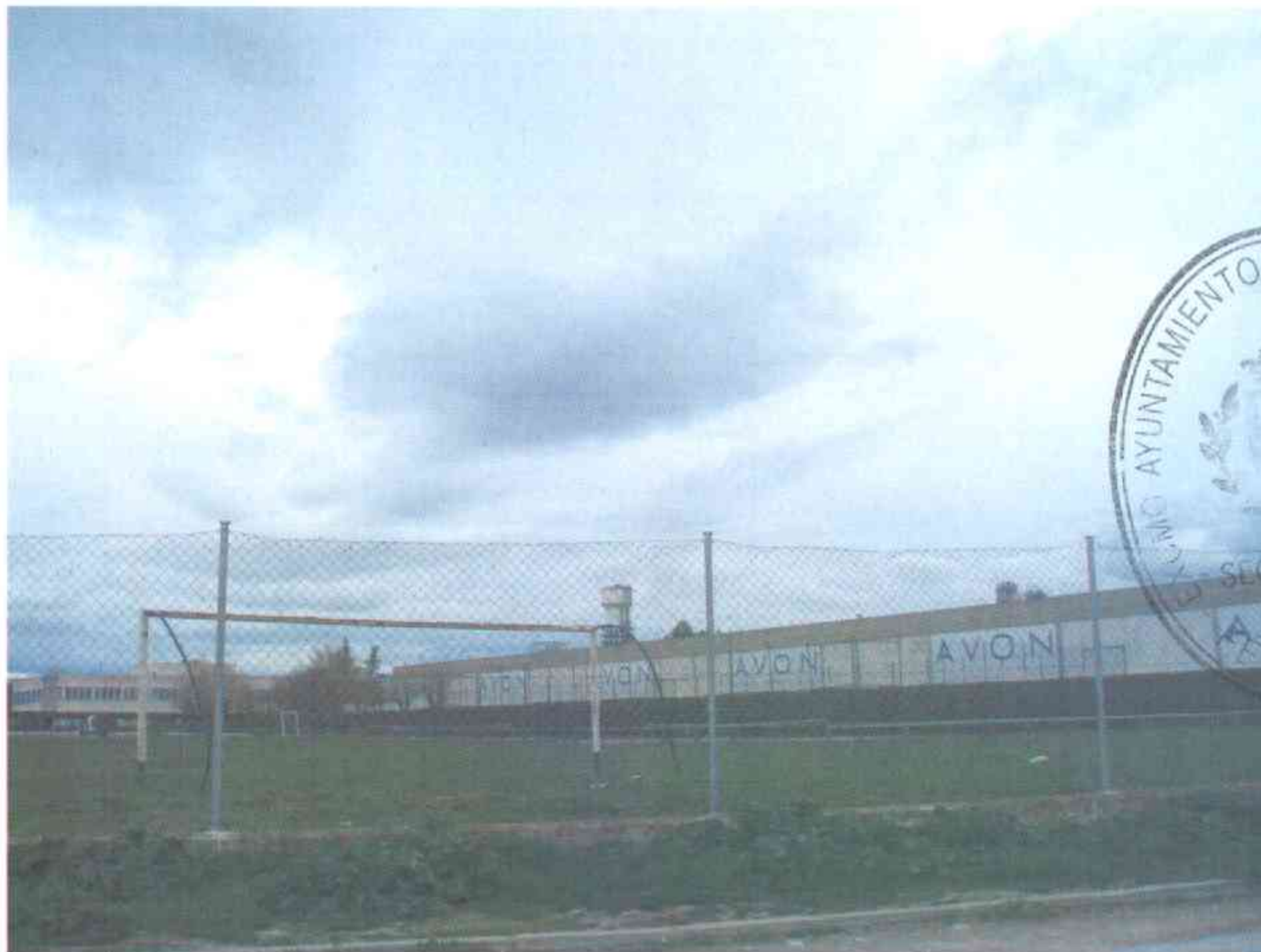
Vista de la nave al este de la zona de estudio, en el denominado Polígono Industrial El Encín.
