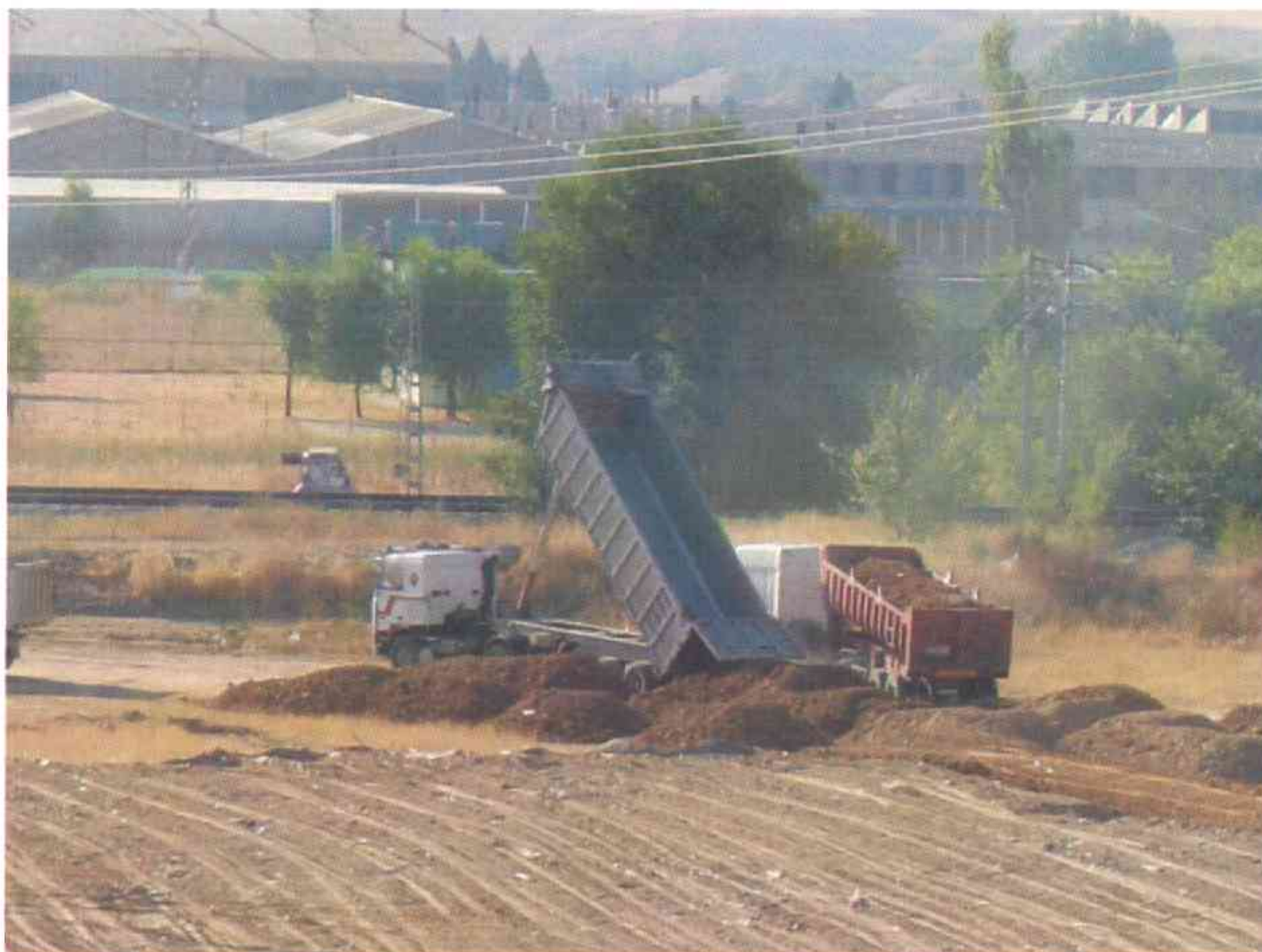
Acopios de tierra vegetal para su reutilización.
