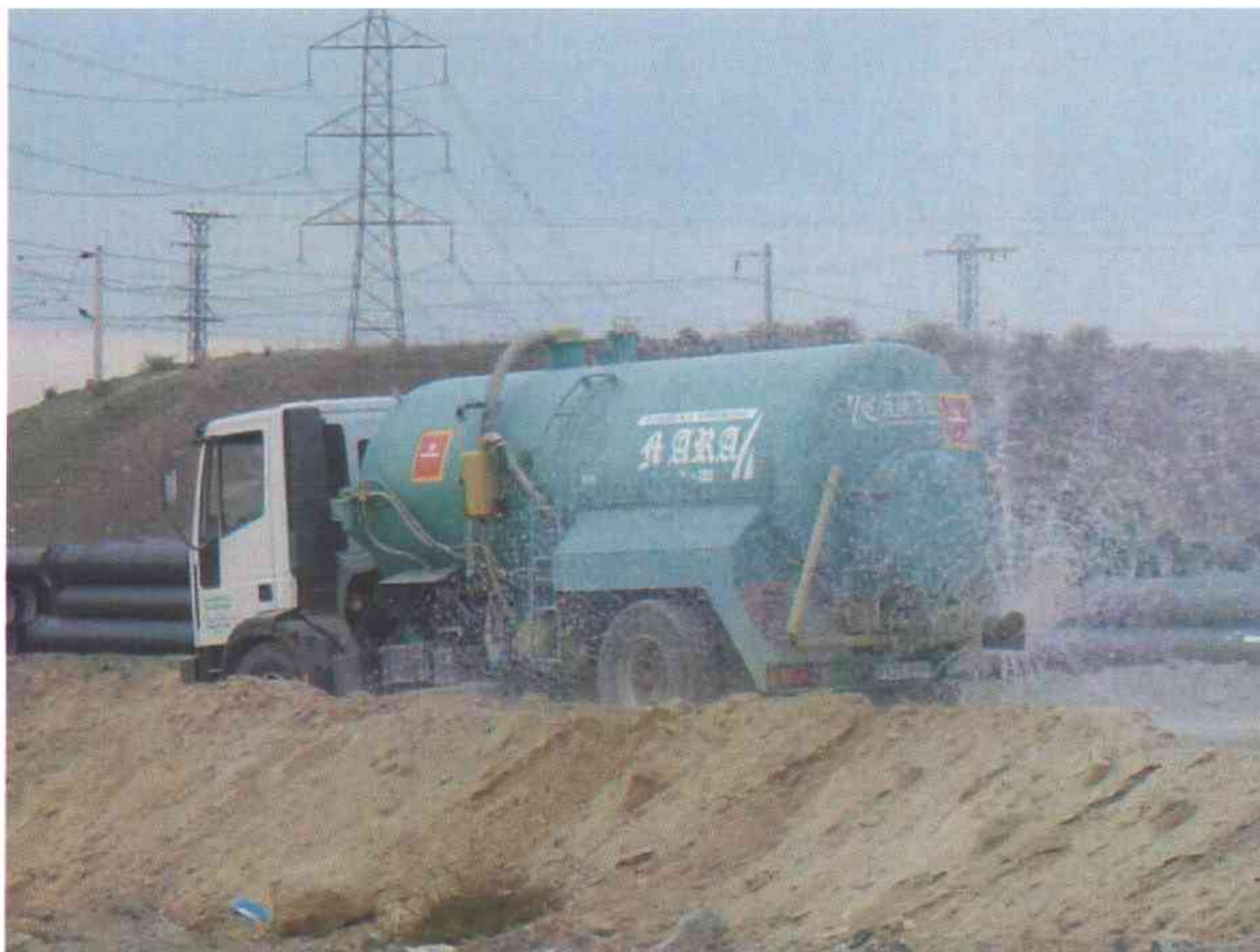
Riegos periódicos para control de la contaminación atmosférica.
